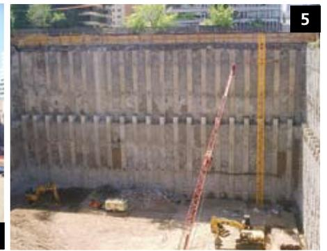
forma mecanizada (pilotes preexcavados), los cuales se emplazan separados entre 2,00 y 3,50 m entre ejes.
