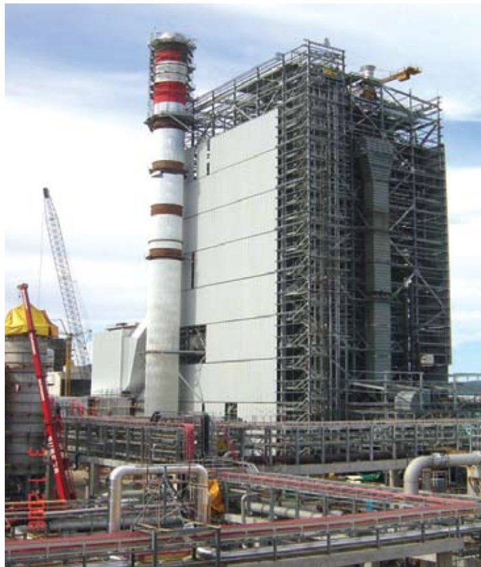
Montaje por dos. Vista de la caldera recuperadora y cómo se fueron montando los paños de 12 metros. Al lado montaje final de la gigantesca chimenea.
