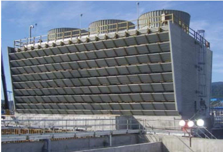
Vista de las torres de enfriamiento de hormigón, en cuya construcción se ocuparon grandes paneles de moldaje de 100 toneladas. En la imagen inferior el tratamiento primario de los efluentes líquidos.
