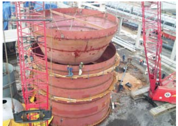
En la línea de fibra uno de los desafíos fue el armado de dos digestores continuos.
