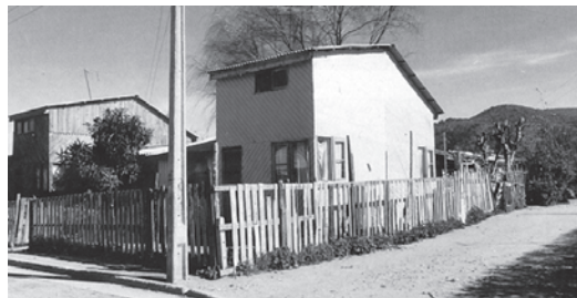
Conjunto Habitacional Aconcagua Sur, Comuna de Quillota, segunda etapa, 18 m 2 en dos pisos, ó 27 m 2 en un piso, 1993. Foto MINVU.
