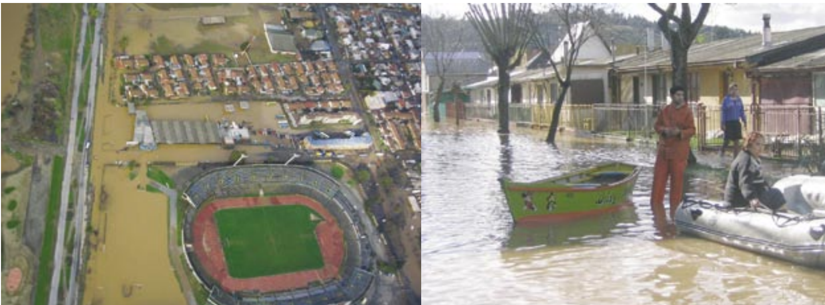
Imagen aérea del Estadio de Collao. Durante julio de este año, la Octava Región se vio muy afectada por las aguas lluvias.
