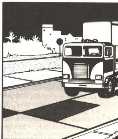
Pavimento transitable sólo 45 minutos después de reparado
