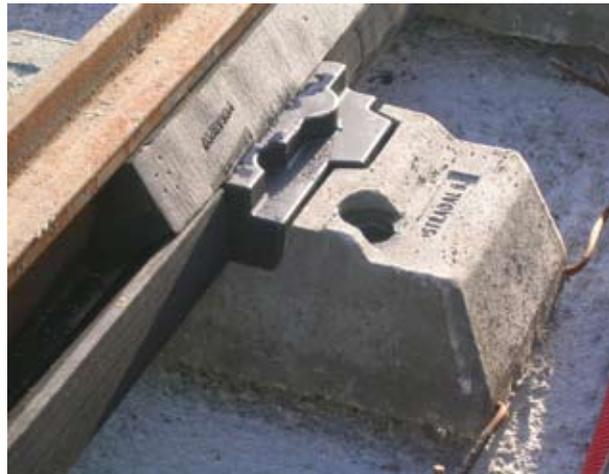
Entre las faenas destaca la instalación de juntas de un material similar al poliestireno expandido entre el durmiere y el riel para evitar las vibraciones.
