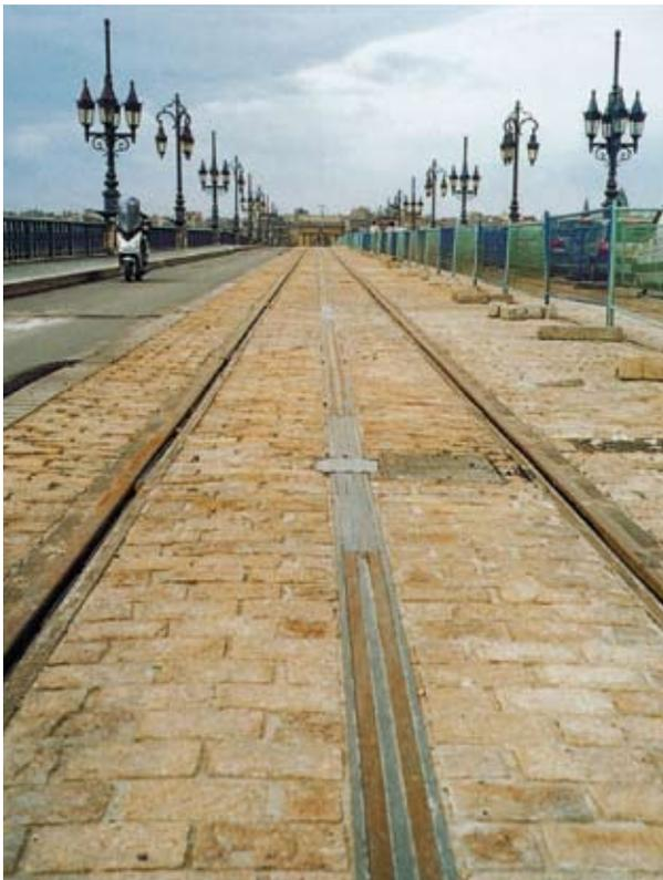
**El Sistema de Alta Alimentación por Suelo (APS) se aplicó por primera vez en el mundo. La electricidad se transmite por un riel intermedio.**
