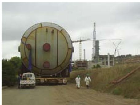
Para transportar los equipos recipientes de coke se analizaron los caminos y puentes existentes entre el puerto y la planta de ENAP.
