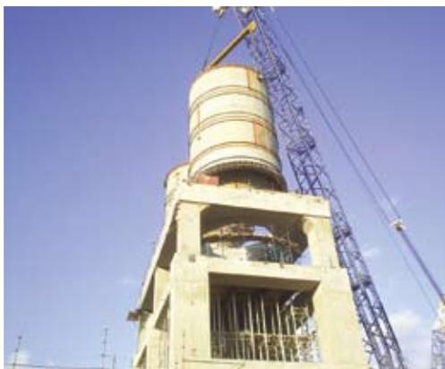
**El montaje de los recipientes de coke se hizo sobre una estructura de hormigón, utilizando una grúa de gran capacidad de 650 toneladas.**
