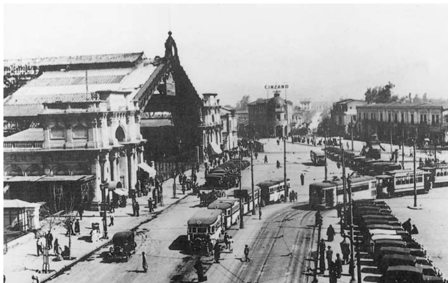
Numerosas líneas de tranvía llegaban al mismo frontis de la Estación Central.
