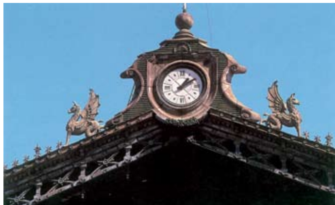
Coronación superior de la estructura metálica.
