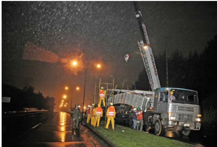
La lluvia no fue impedimento para el montaje de la pasarela. Un andamio instalado en el bandejón central sostuvo por unos instantes una de las vigas.
