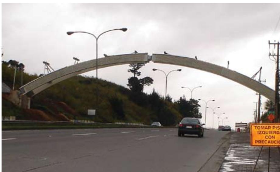
La pasarela se compone de arcos de madera laminada de 9,9 m de altura en la articulación central.
