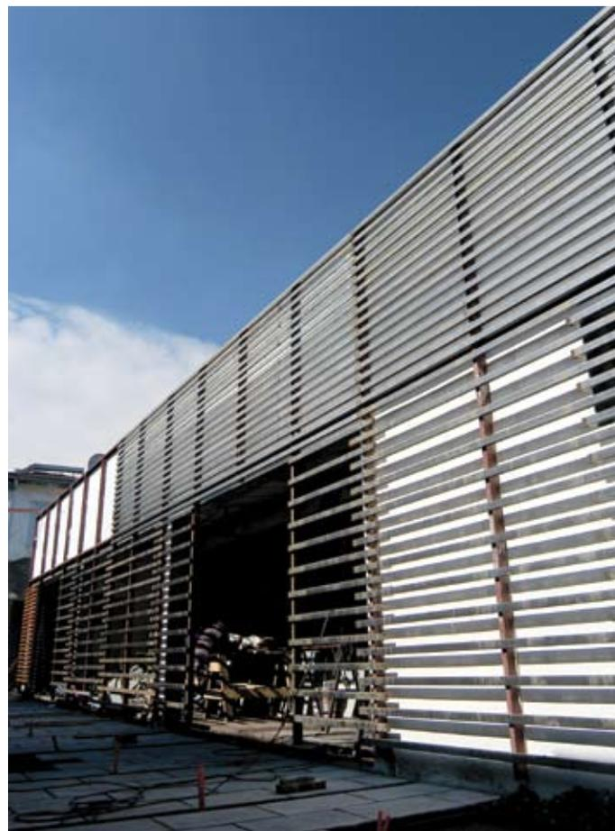
La incorporación de nuevos elementos está dada por el recubrimiento de los galpones y algunas fachadas interiores con celosías de hierro oxidado, que aportan iluminación gracias a la incorporación oculta de tubos fluorescentes en la parte superior.
