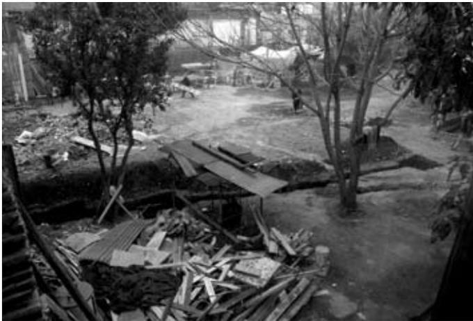
ban una ampliación hasta Pío Nono. "Partimos por el cité ubicado en Constitución demoliendo muros medianeros y limpiando, cuidando no afectar las características de las fachadas que posteriormente se recuperaron. Se podría decir que en general se dejó el cascarón de la obra original y se cambiaron cubiertas, pisos y techos", comenta Patricio Bannura, Constructor del proyecto.
