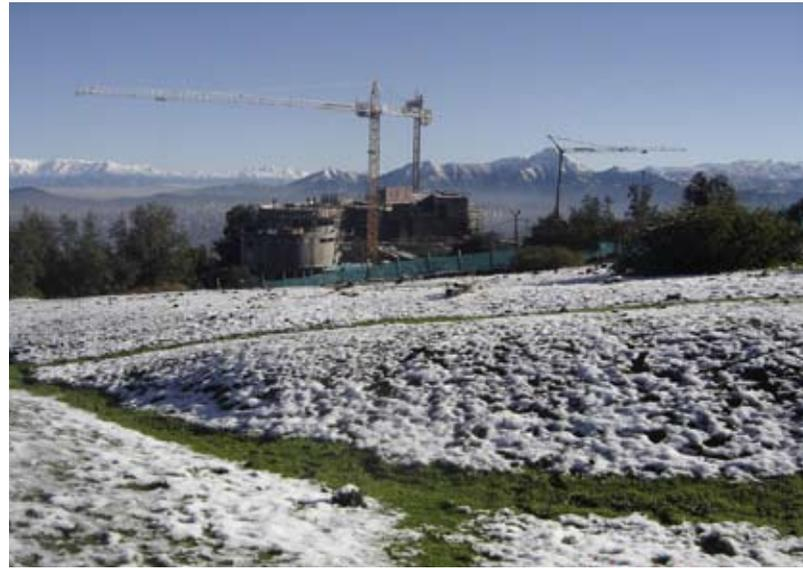
**La nieve resultó un elemento pintoresco en la ejecución de la obra. Sin embargo planteó desafíos en el hormigonado, porque esta faena no se puede realizar a temperaturas bajo cero.**
