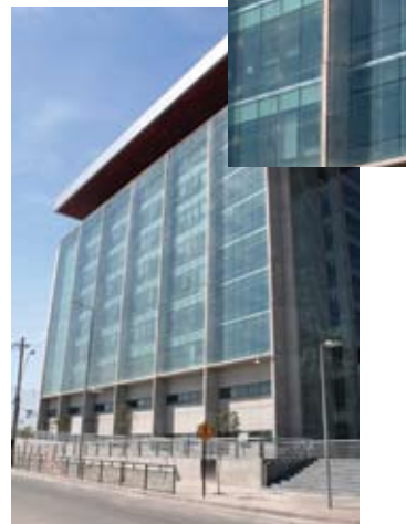
Edificio Centro de Justicia de Santiago Avenida Pedro Montt N° 1606 – Santiago Constructora OHL Fabricante Ingewall Chile Ltda Arquitectos: Cristian Boza y José Macchi
