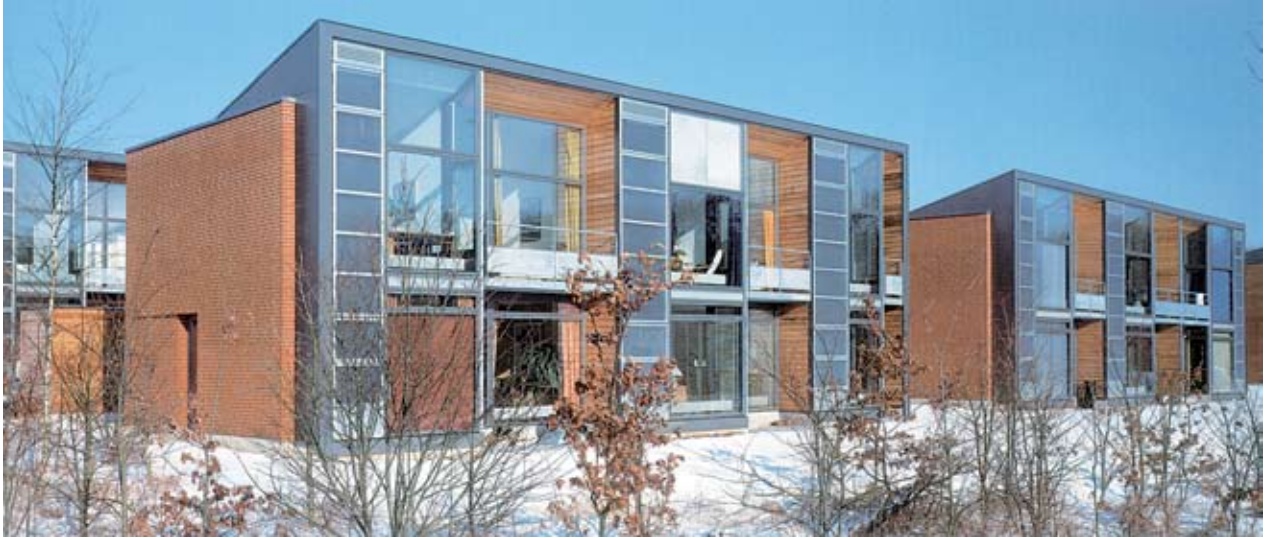
Conjunto de viviendas en Dinamarca: Las casas disfrutan de orientación norte-sur, los muros norte constan de aislamiento y la fachada sur está completamente acristalada y aislada.
