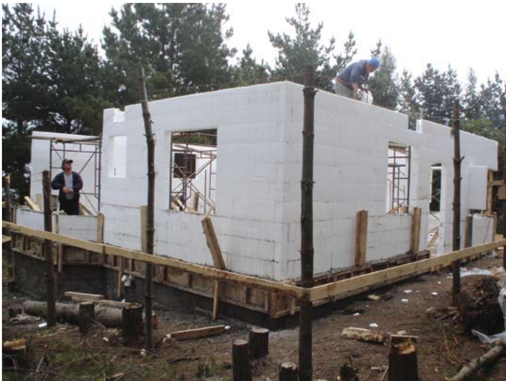
Aplicación de ladrillos livianos de poliestireno expandido en viviendas del litoral central.
