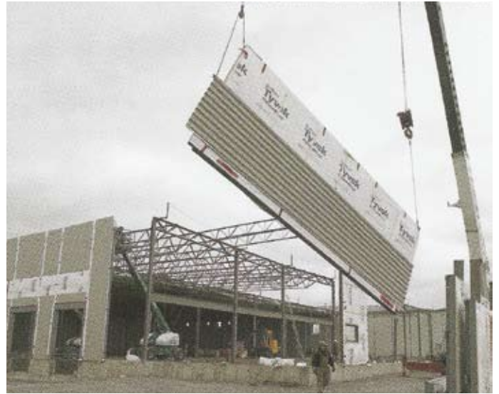
INNOVACIÓN DE CANADÁ: Moldajes de poliestireno expandido incorporado.
