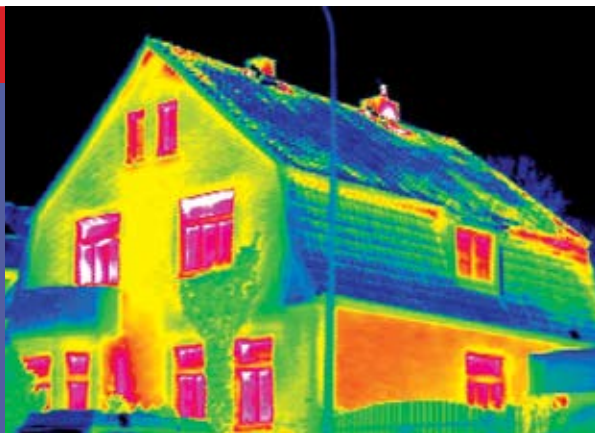
Termografía que muestra los puentes térmicos de una vivienda.
