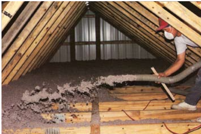
Proyección de celulosa aislante en un ático de vivienda.
