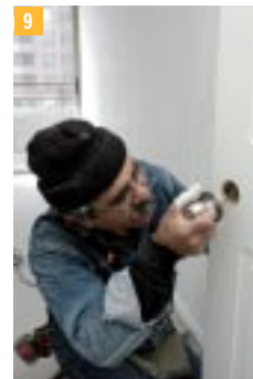
9 Instalación de cerradura
