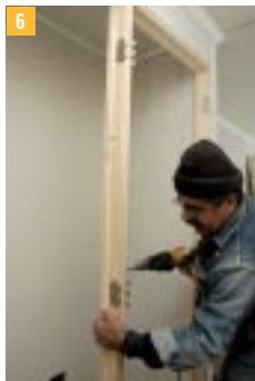
6 Instalación de visagras en marco
