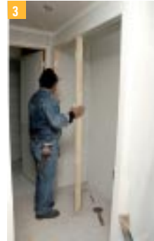
3 Presentación e instalación del marco en el vano.
