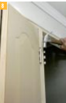
8 Instalación de pomel o pasador de visagra
