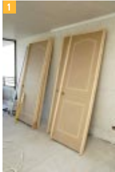
1 Almacenamiento y aclimatación de puertas.
