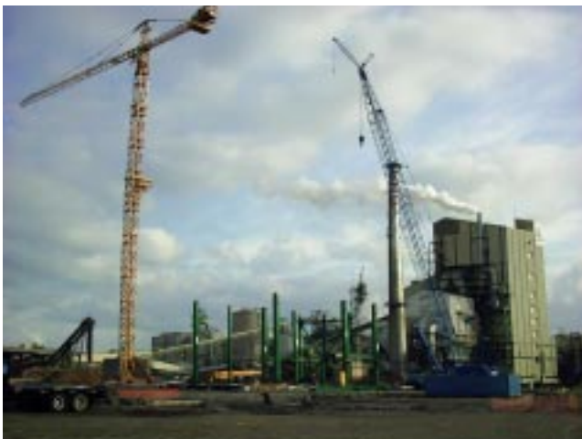
Grúa Torre Potain
