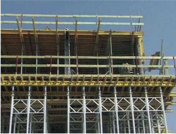
Sistema de moldajes Alu- Top, se compone de superficies prearmadas y piezas livianas de 25 kilos.
