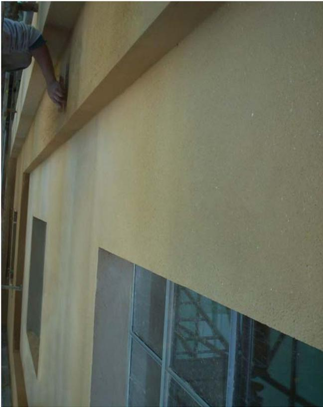
En el recubrimiento de las fachadas se renovaron 10.000 m<sup>2</sup> de litofrén, especie de estuco con color incorporado.
