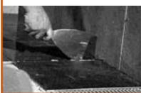
8 La aplicación del fragüe es tan importante como la instalación, pues evitará que las filtraciones de agua o acumulación de humedad en el recinto penetren bajo la cerámica.
