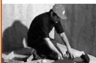
5 Los adhesivos modernos (polvo) y premezclados requieren de una preparación previa de 10 a 12 minutos para que todos sus componentes se hidraten adecuadamente, para luego volver a remover.
