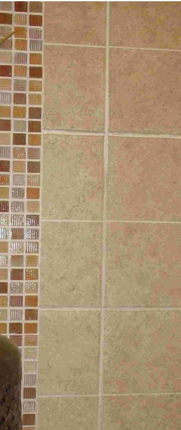
La cerámica constituye un recubrimiento adaptable a cualquier superficie, de dimensiones variables, canterías precisas y altas exigencias en tiempos de fraguado. Según su proceso de fabricación, se utiliza en muros, pisos y como elemento de decoración.
