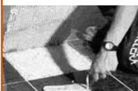
7 La postura de la palmeta requiere cierta presión o golpes superficiales, logrando una adecuada nivelación y un contacto efectivo entre adhesivo y palmeta (mientras mayor sea la superficie de contacto, con un mínimo de 80 %, mayor será la resistencia).
