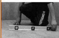
2 Se deben revisar los niveles en cada punto del área de piso. Para esto se puede utilizar el sistema de nivel-manguera con agua, marcando en uno de los muros a una altura de un metro.
