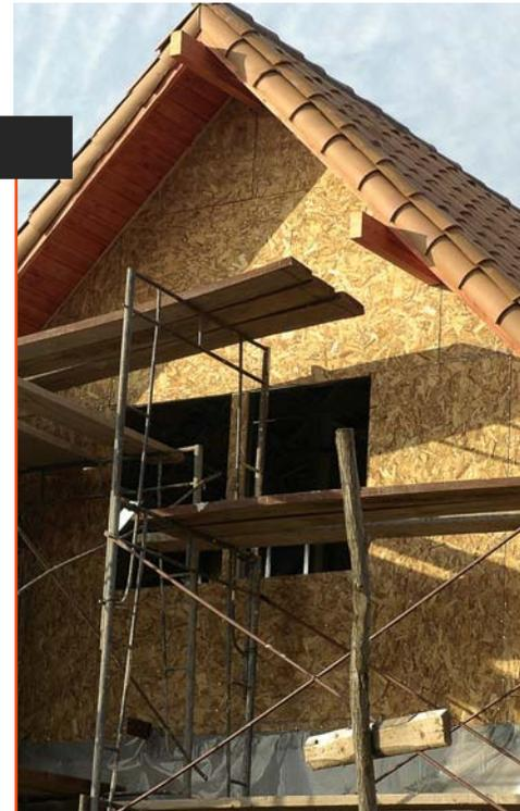
La constructora Sepeco realiza aislaciones térmicas por el exterior con paneles de OSB y una capa de poliestireno expandido de 30 mm más una malla de fibra de vidrio.
