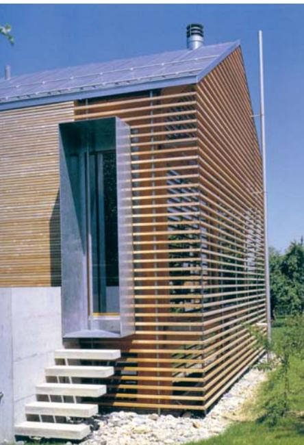
Las fachadas hacia el sol deben tener un filtro (fijo o móvil) para controlar la luz. Ejemplo de una casa en Suiza.
