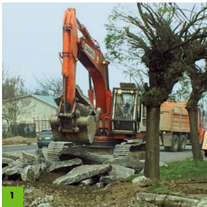
1 Extracción del material.
