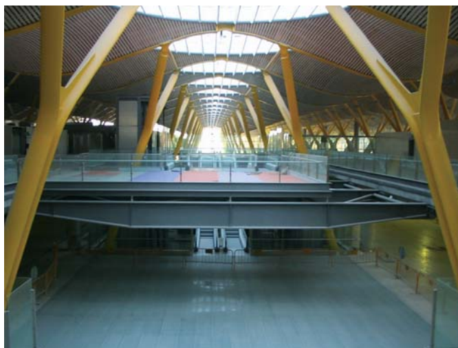
Ampliación del Aeropuerto de Barajas en Madrid.
