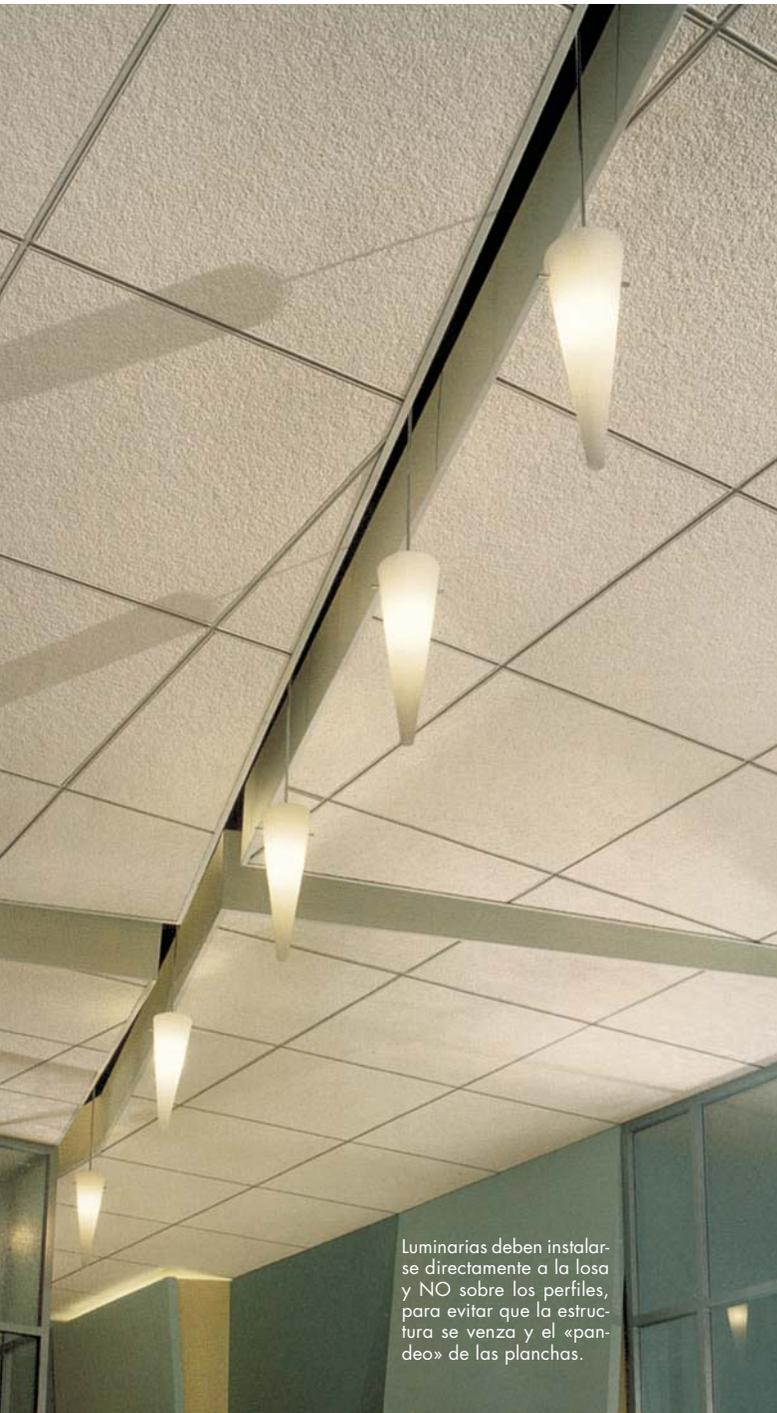
Luminarias deben instalarse directamente a la losa y NO sobre los perfiles, para evitar que la estructura se venza y el «pandeo» de las planchas.
