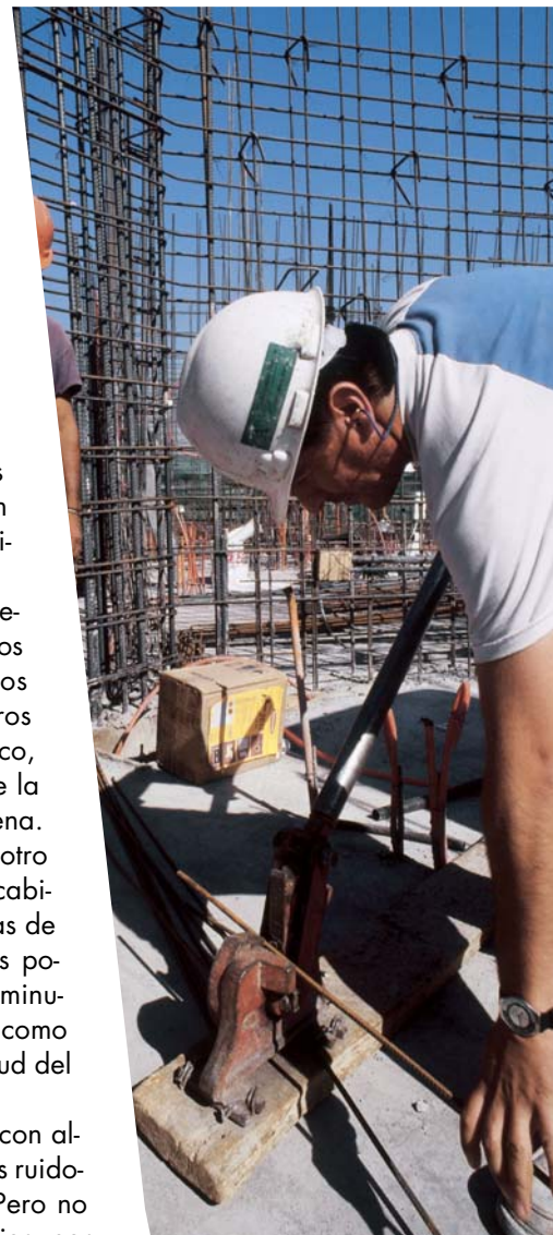
Los cortes con guillotinas disminuyen el ruido en obra.
