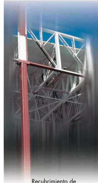
Recubrimiento de estructura metálica con pintura intumescente.
