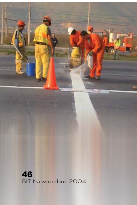
Aplicación de Pintura Tráfico.
