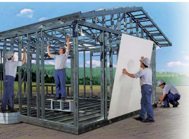
Entre los productos especificados de Cintac está Metalcon, perfiles estructurales de acero.
