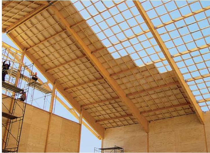
Bodega de sales ubicada en la VIII Región. Techo compuesto por Hilam (madera laminada), revestimiento de terciado estructural y costaneras de MSD estructural, todos productos especificados por Arauco.
