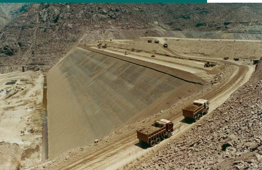
Avance de los rellenos de transición del talud de aguas arriba y masivos al fondo.
