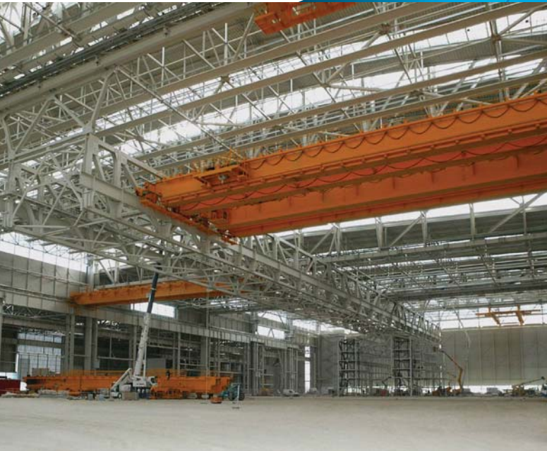
En el armazón del hangar se utilizaron 22.000 toneladas de acero.
