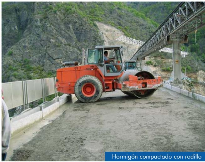
Hormigón compactado con rodillo
