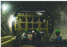
Encofrado para Hormigonar Paredes de Losa Superior
