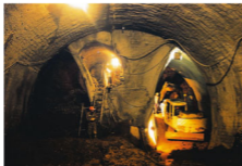
Excavación del Túnel Principal
