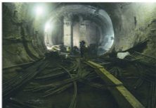
Túnel Principal con Pilas de Soportado a la Vista
