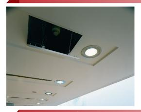
Las Puertas de Registro Knauf permiten un fácil acceso a cielorrasos para la revisión el funcionamiento y mantención de las instalaciones. Está compuesta de un marco de aluminio reforzado y una tapa desmontable con una placa de yesocartón, incorporándose perfectamente a la estética de los sistemas constructivos. Cuenta con un sistema seguro de cierre.
