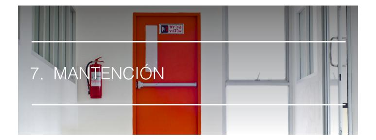
La mantención de las puertas cortafuego debe realizarse periódicamente en función de su uso y recomendación del fabricante, en caso de no contar con la Ficha Técnica del producto se recomienda realzar mantención una vez por año para puertas de uso eventual (zona vertical de seguridad) y cada tres meses en el caso de tránsito permanente.
