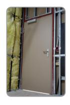
Generalmente esta estructura es requerida en una construcción de perfilería de acero, donde se irá a montar la puerta (en los casos de puertas de madera en ocasiones el marco se embute en obra húmeda o tabique).
