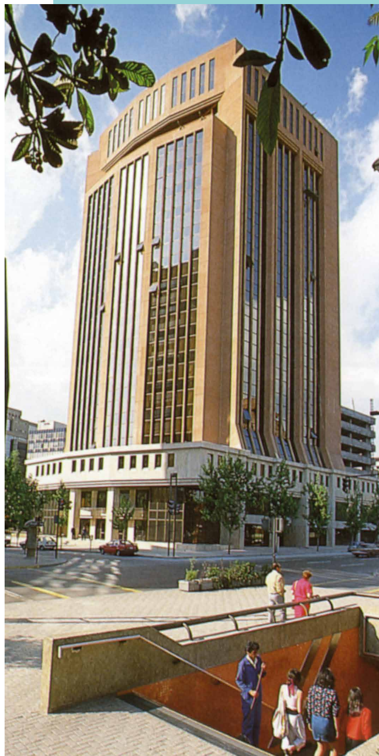
Vista del edificio de la CChC en calle Marchant Pereira. 1989
