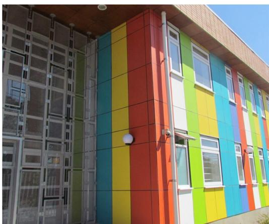
Eterplac es una Placa cementicia para fachadas modulares con distintas geometrías, rectificadas y calibradas logrando así la mejor superficie para recibir la aplicación de pintura en base agua, sin limitantes de color.
