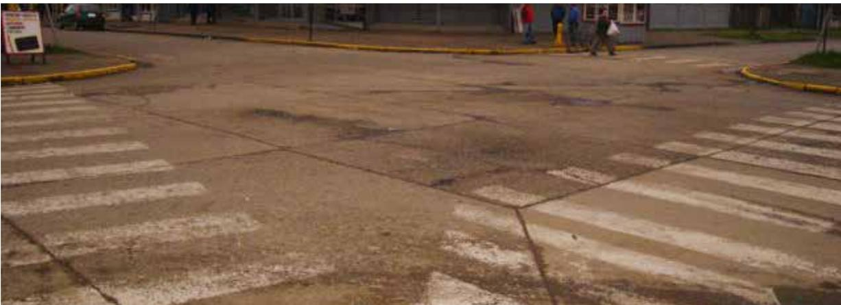
Cruce con deficiencia en mantención de demarcación horizontal.
