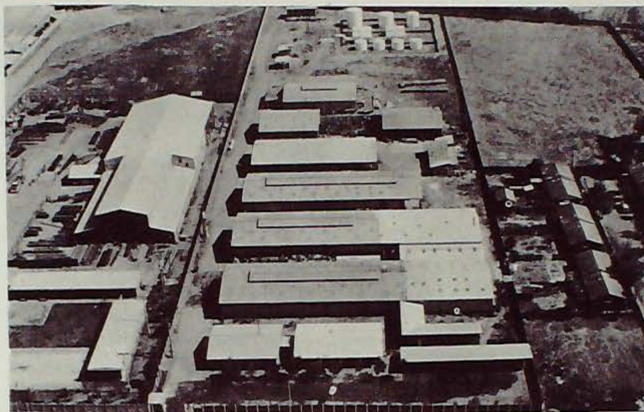
Vista aérea de Fábrica y Oficinas Generales.
