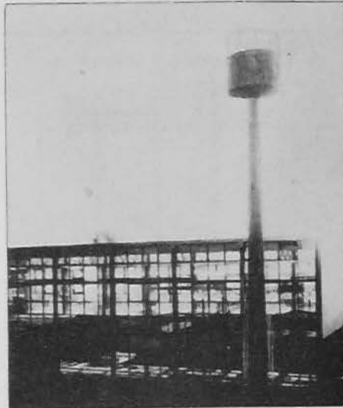
Estanque Elevado U.T.E.
