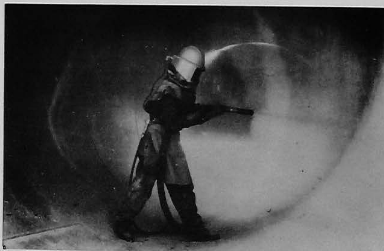
Arenado de estanques
