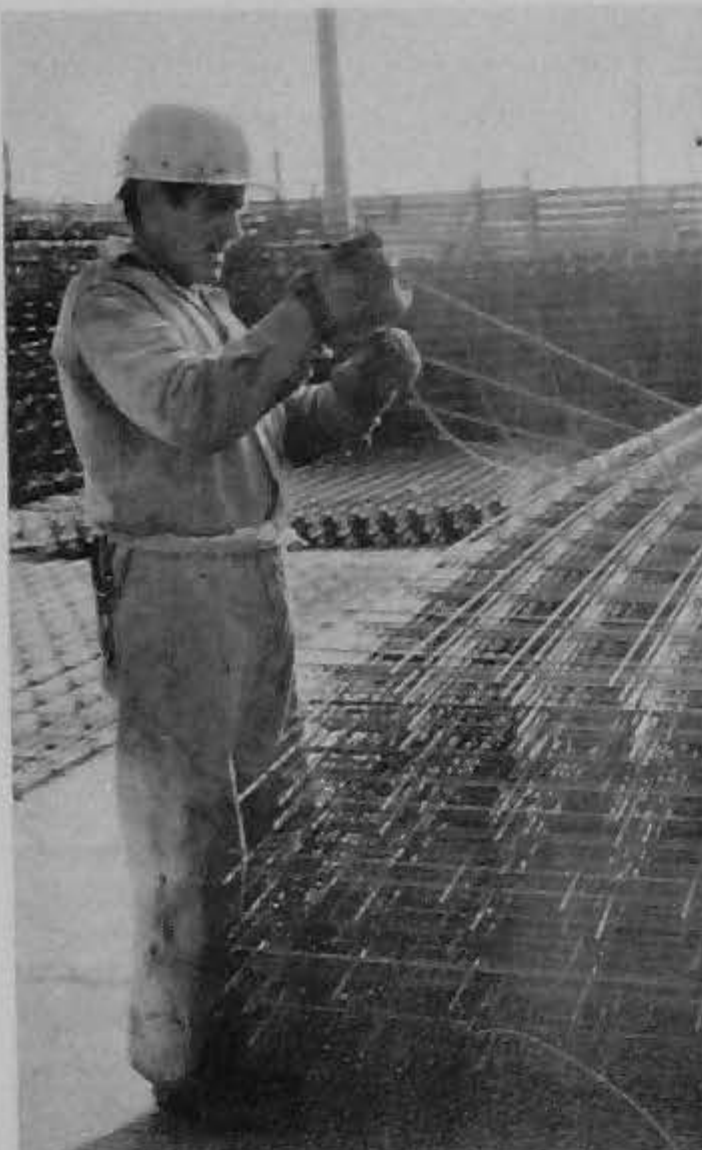
FAENA DE COLOCACION DE MALLAS "ACMA"
