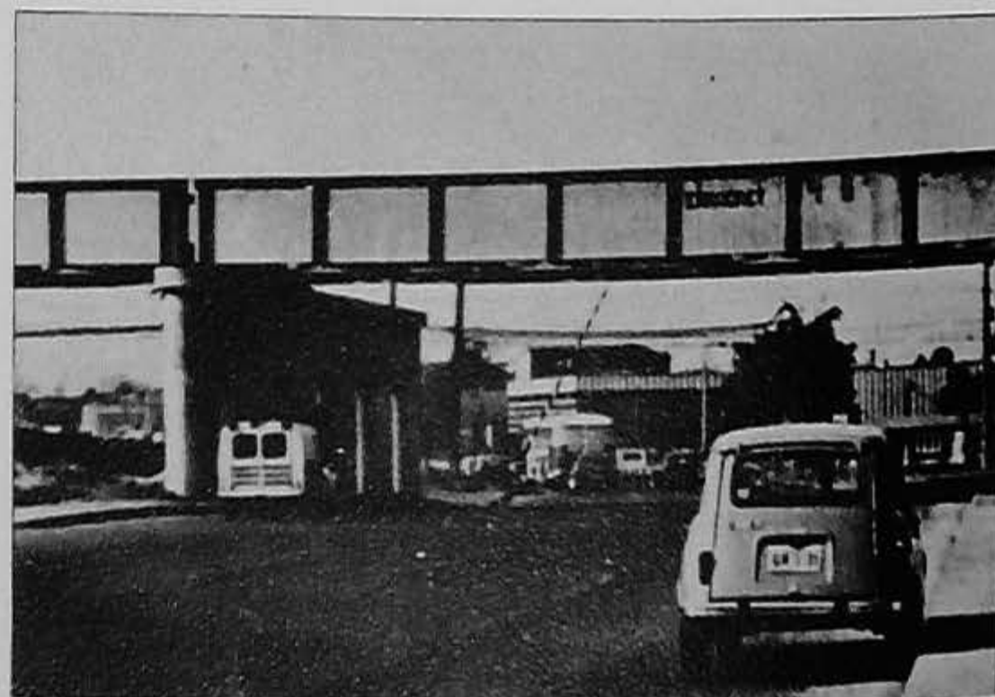
Puente ferroviario en salida Norte Santiago.
