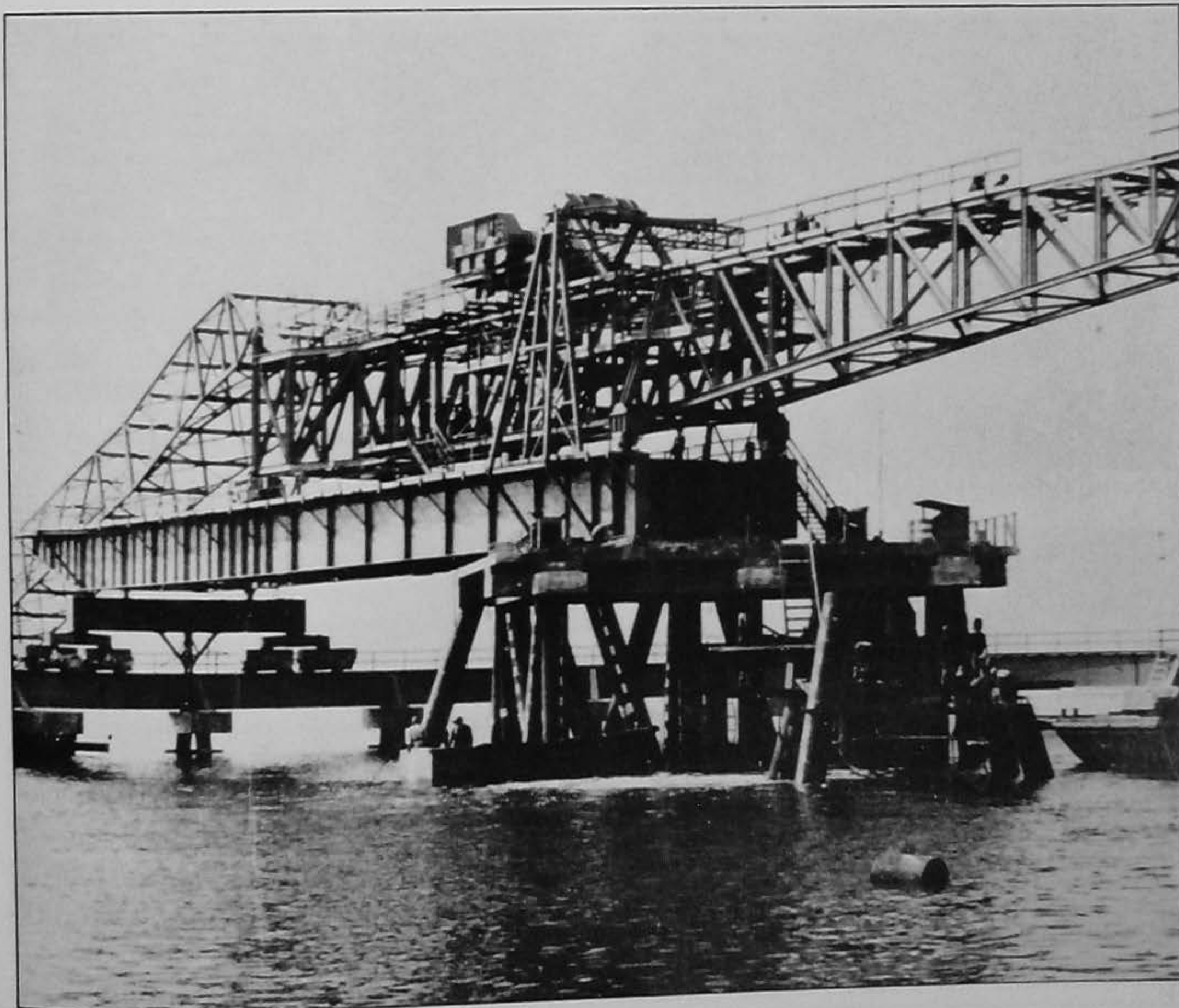
Puerto Guacolda II - Planta Pellets CAP
