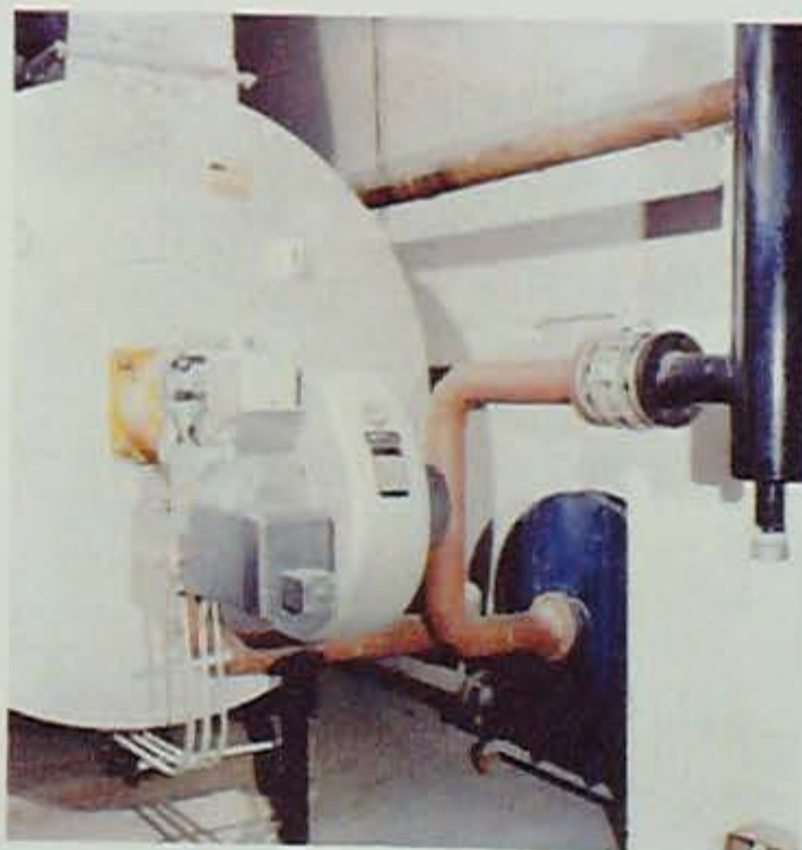
Caldera a gas para uso en calefacción y agua caliente instalada en edificios de departamentos.
