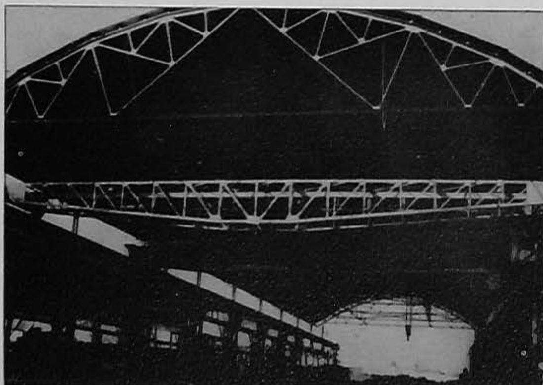
Puentes grúas para 10 a 20 tons. y con 25 mt. de luz.
