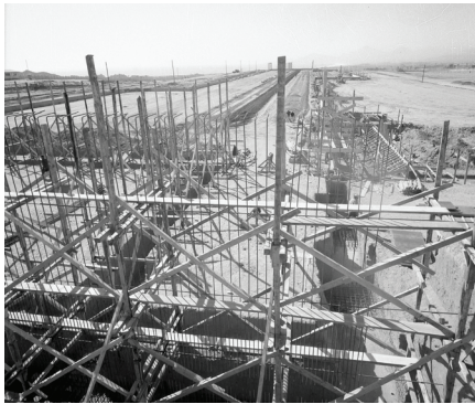
Ejemplos de construcción a mediados del s. XX con andamios de maderas y antiguas mezcladoras.
