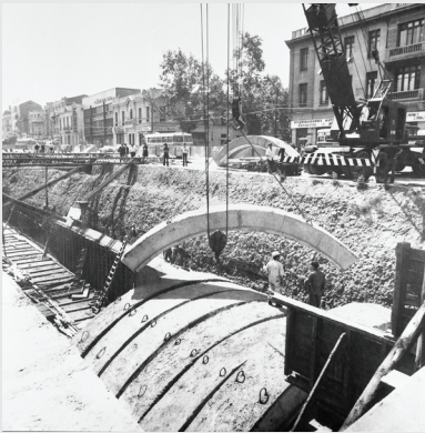
| Inicio construcción Metro de Santiago. Jack Ceitelis
