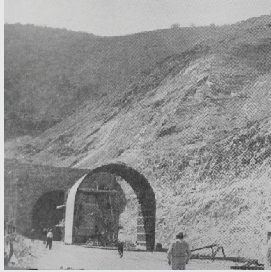
| Túnel Lo Prado
