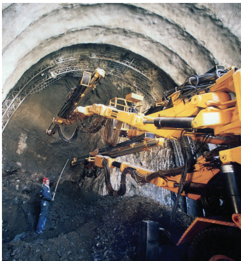
Construcción del acceso sur del túnel El Melón, Luis Ladrón de Guevara, 1993. Obra realizada por la Concesionaria Túnel El Melón, conformada por Endesa, Delta y Agroman.
