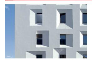
Sistema de aislación térmica y terminación exterior contínua.
