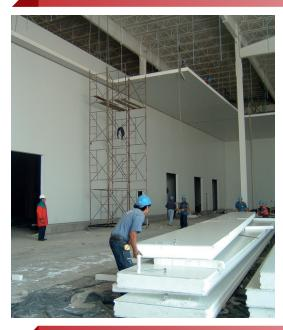
El PANEL RUDNEV® resiste perfectamente a diversas condiciones de intemperie y corrosión, gracias a la pintura de poliéster de la lámina de acero. A su vez, mantiene condiciones de higiene y limpieza interior, pues la superficie del panel es fácilmente lavable. El panel presenta, además, gran resistencia a solicitaciones mecánicas horizontales o verticales.
