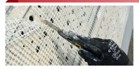
WEBER DIRECT APPLIED PLACAS OSB corresponde a un sistema de revestimiento exterior aplicado de forma directa sobre placas de OSB que incorpora una Malla Orange de fibra de vidrio, la cual va embebida dentro de una capa milimétrica de mortero elastomérico, que posteriormente se refuerza con una segunda capa, también milimétrica, del mismo mortero; como terminación final se incorpora capa de grano elastomérico texturado y con color incorporado.
