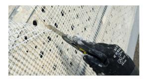
WEBER DIRECT APPLIED Placas corresponde a un sistema de revestimiento exterior aplicado de forma directa sobre cualquier tipo de placa, que incorpora una Malla Orange de fibra de vidrio, la cual va embebida dentro de una capa milimétrica de mortero elastomérico, que posteriormente se refuerza con una segunda capa, también milimétrica, del mismo mortero; como terminación final se incorpora capa de grano elastomérico texturado y con color incorporado.
