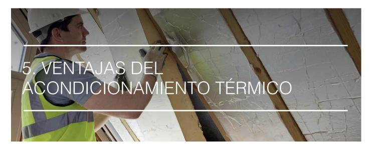
Se debe tener en cuenta que para que la solución de acondicionamiento térmico cumpla con los beneficios descritos en los recuadros siguientes, en cada caso debe utilizarse los materiales adecuados, con una correcta instalación y con los complementos que sean necesarios tales como barrera de vapor, barrera de humedad, espacio para ventilación.
