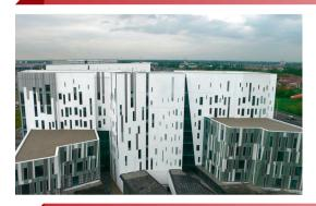
Knauf AQUAPANEL® EIFS sistema de fachadas para edificaciones que requieren mayor aislación térmica. Las placas cementicias AQUAPANEL® Cement Board Outdoor o AQUA-PANEL® Cement Board Universal conforman el sustrato base al cual de adhiere el aislamiento y los acabados de morteros elastoméricos.
