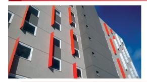
Knauf AQUAPANEL® sistema de fachadas a base de placas cementicias AQUAPANEL® Cement Board Outdoor o AQUAPANEL® Cement Board Universal. Las placas cementicias se conforman por cemento Portland y aditivos aglomerantes inorgánicos y están contenidas por una malla de fibra de vidrio. Alta resistencia a la humedad, agua y condiciones climáticas adversas, evita la formación de hongos y moho, robusta, durable y estable dimensionalmente, resiste cambios de temperatura.
