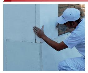
Las PLANCHAS PARA AISLACIÓN EXTERIOR DE AISLA-POL® son especialmente adecuadas para la solución constructiva de aislación térmica exterior, de alta densidad y resistencia mecánica, fabricadas en Chile por Aislapol S.A.
