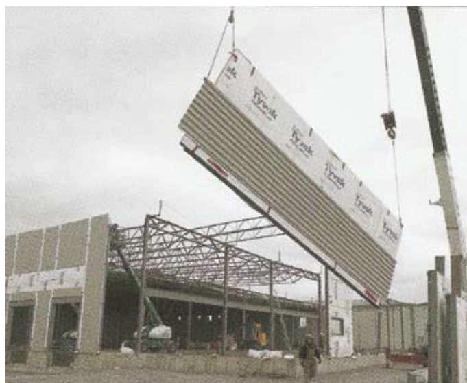
INNOVACIÓN DE CANADÁ: Moldajes de poliestireno expandido incorporado.
