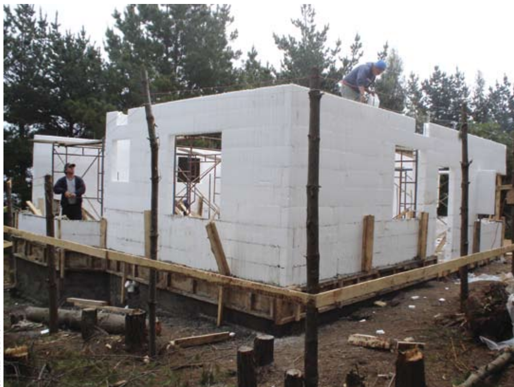
Aplicación de ladrillos livianos de poliestireno expandido en viviendas del litoral central.
