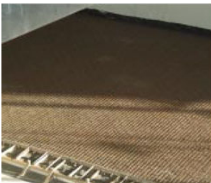
Se usaron 6 paños de 18x28 metros los que cubrieron la losa del recinto.
