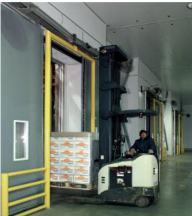
La lisura y planitud de los pavimentos fue lograda gracias a las exigencias de las especificaciones técnicas. Se consiguió una óptima velocidad de desplazamiento de los apiladores y transpaletas.
