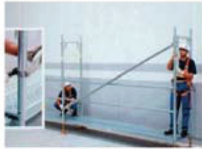
Colocar la diagonal con abrazadera.
