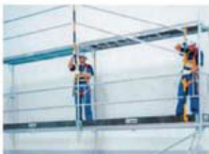
Colocar las plataformas y repetir la operación del punto (*) tantas veces como sea necesario hasta terminar el montaje.
