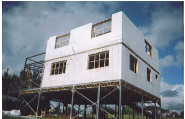
La instalación de ladrillos de poliestireno expandido resulta rápida y simple gracias a su bajo peso: Un metro cuadrado del modelo 250 pesa 3 k y del 125 pesa 1 kilo. (Exacta)
