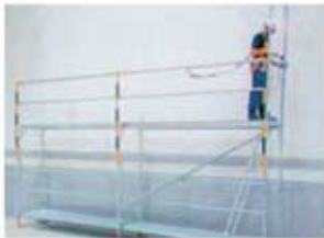
Colocar los marcos. Utilizar protección individual.
