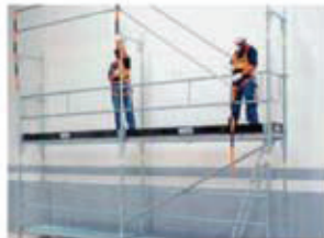
Repetir la operación del punto (*) para continuar con el montaje.
