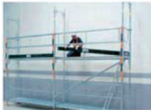
Colocar las barandillas y los rodapiés.
