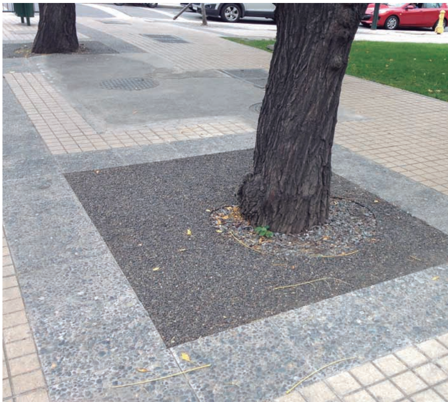
ALCORQUE DRENANTE, LAS CONDES, SANTIAGO
