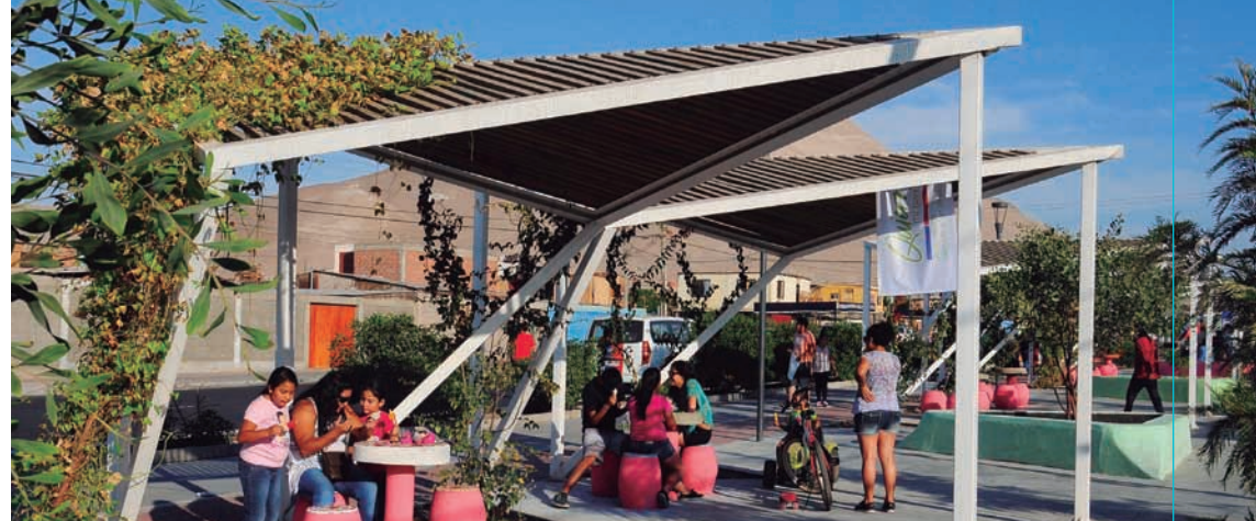
ELEMENTOS DE PROTECCIÓN SOLAR EN PLAZA DE BARRIO CHILE, ARICA
