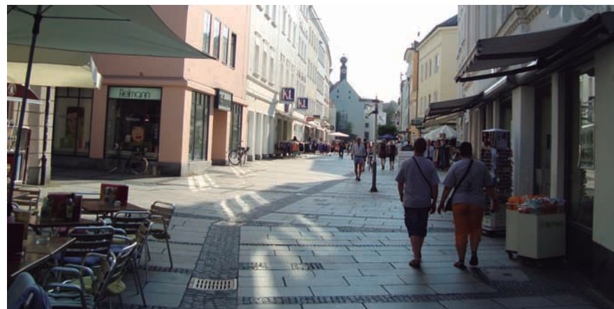
ELEMENTO CENTRAL DE CANALIZACIÓN DE AGUAS EN PASEO PEATONAL EN PASSAU, ALEMANIA
