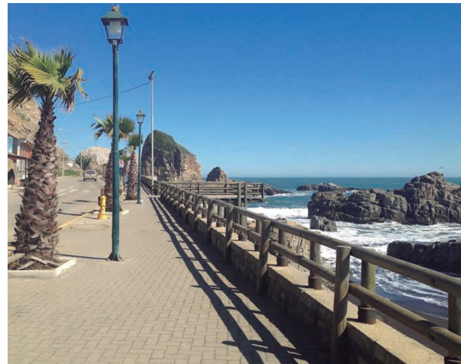
ADOQUÍN EN HORMIGÓN EN LA COSTANERA EN CONSTITUCIÓN
