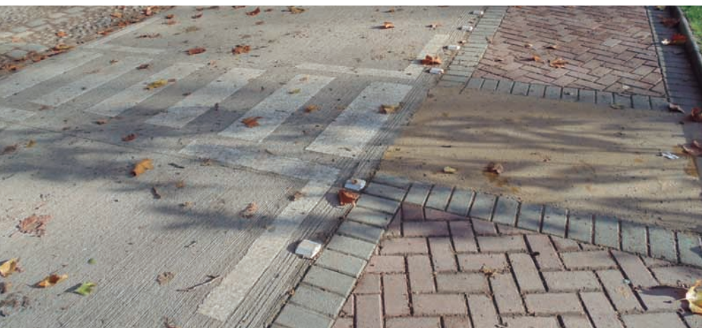
PAVIMENTO EN PARQUE ECUADOR, CONCEPCIÓN
