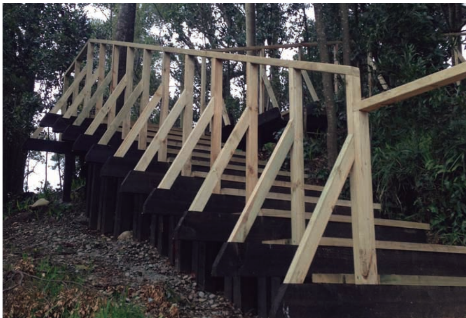
BARANDA DE MADERA TRATADA CONTRA LA HUMEDAD, PUERTO VARAS
