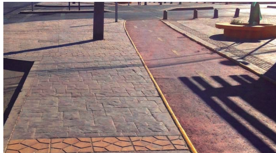
VEREDA EN PAVIMENTO IMPRESO Y CICLOVÍA, CALAMA
