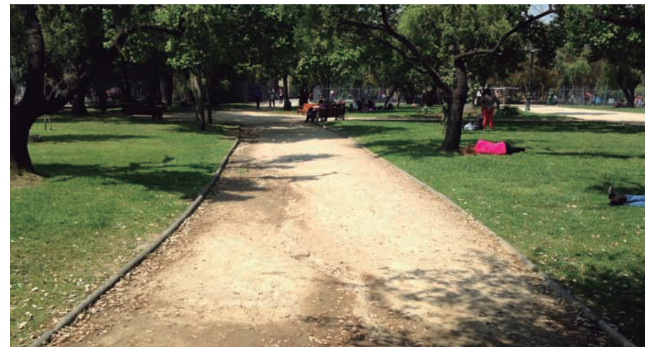
SENDERO DETERIORADO POR RIEGO EN PARQUE ARAUCANO, LAS CONDES, SANTIAGO
