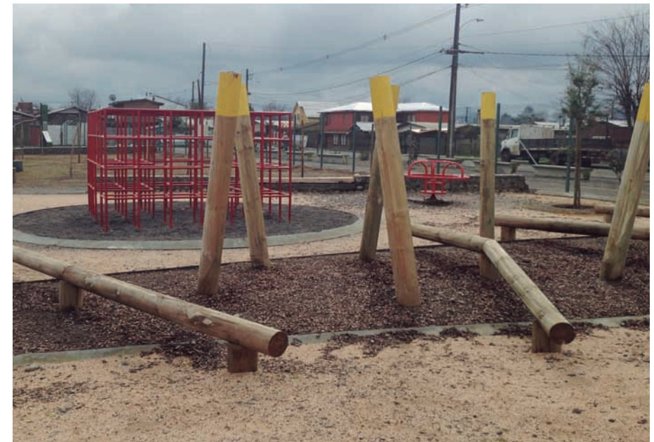
PAVIMENTOS BLANDOS EN PARQUE RIVERA VENECIA, TEMUCO
