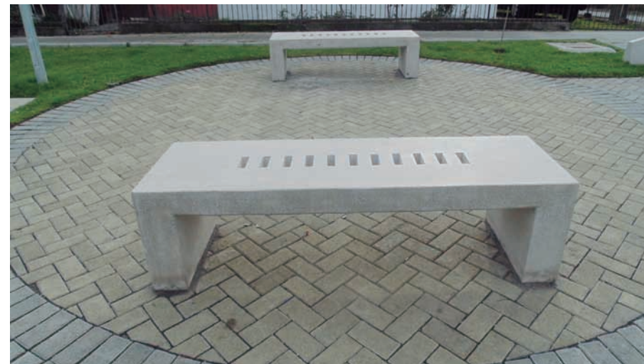
BANCO CON ORIFICIOS PARA EVITAR ACUMULACIÓN DE AGUA, CORONEL
