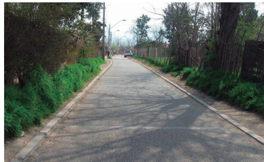
PASAJE DE HORMIGÓN DRENANTE, CALERA DE TANGO
