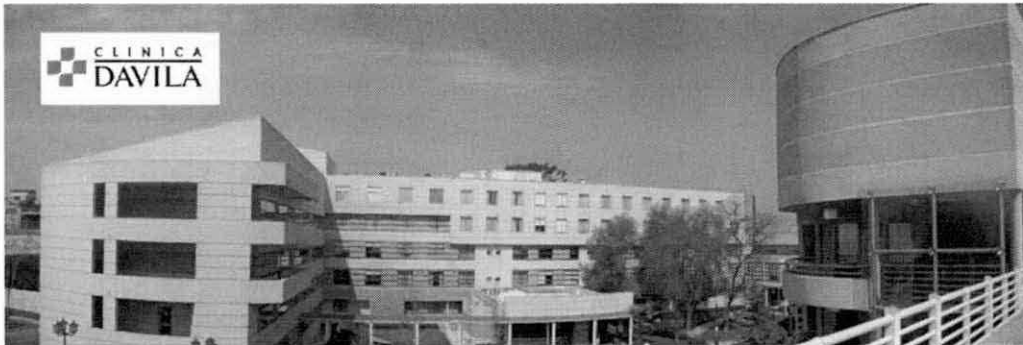
Instalación ejecutada Proyección de la Disminución del Costo Operacional para ACS al año: 84%
