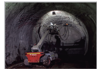
Refuerzo bóveda de túnel mediante anclajes
