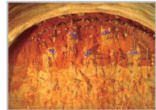
Refuerzo de frente de túnel con Jet-grouting
