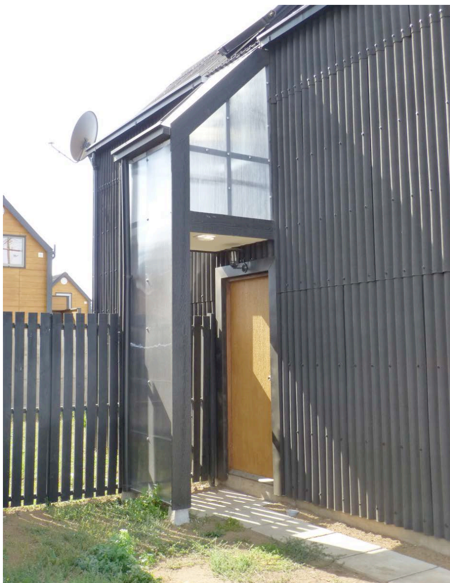
Figura 10.4: Protección del acceso y espacio solar
