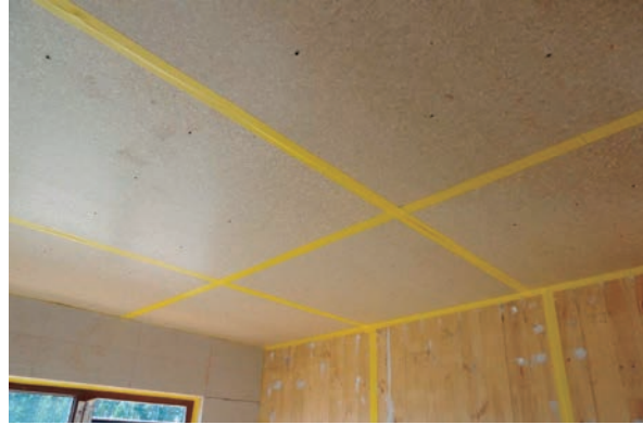
Figura 10.30: Cintas de sellos entre paneles por el interior
