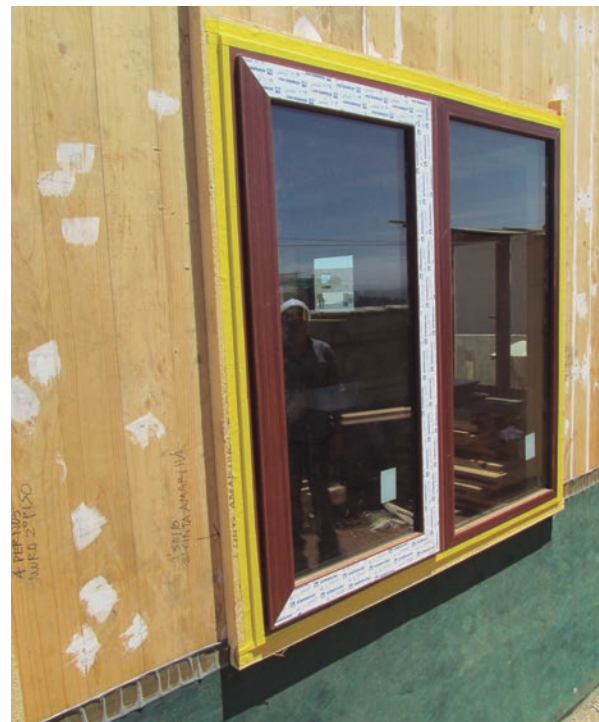
Figura 10.34: Sellos en unión marco-muro, por el exterior
