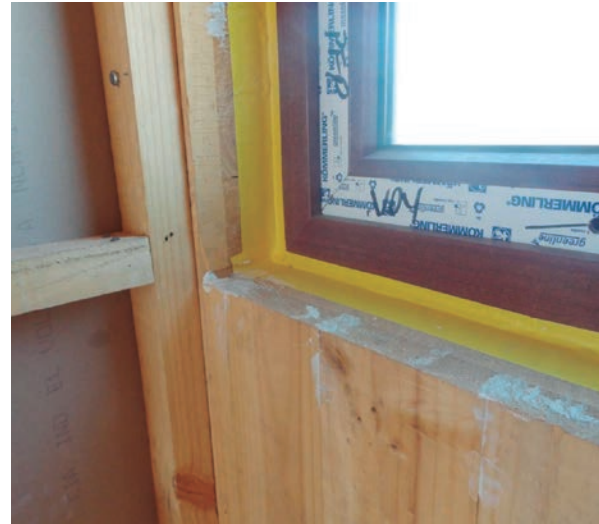
Figura 10.33: Sellos en unión marco-muro, por el interior
