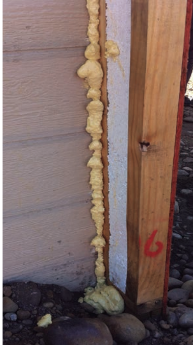
Figura 10.10: Sello de poliuretano inyectado en unión entre placa de revestimiento y estructura de madera
