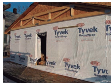
Figura 7.7 y Figura 7.8: Instalación a la envolvente estructurada en madera de la membrana fibra propileno por los paramentos exteriores.
