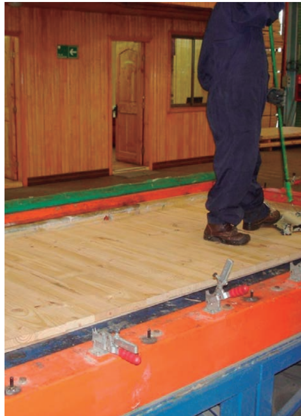
Figura 10.22: Prefabricación de los paneles de CLT
