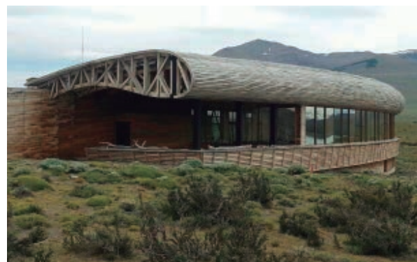
Figura 8.7: Hotel Tierra Patagonia en Torres del Paine (arqto. Cazú Zegers).
