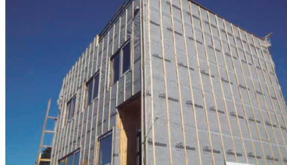
Figura 10.31: Membrana de barrera al viento
