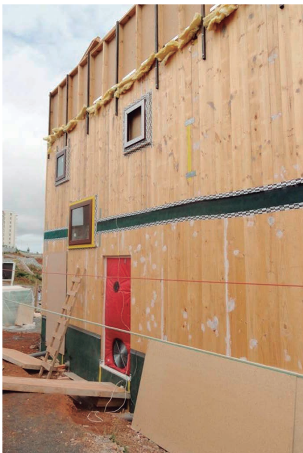
Figura 10.40: Ensayo Blower Door en etapa de obra gruesa
