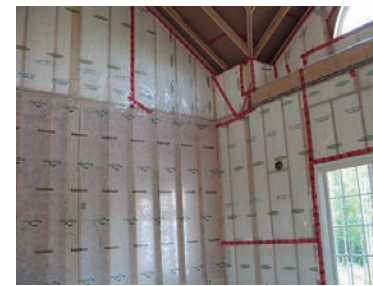
Figura 7.6: Sello de hermeticidad al aire en unión entre marco de puerta y muro.
