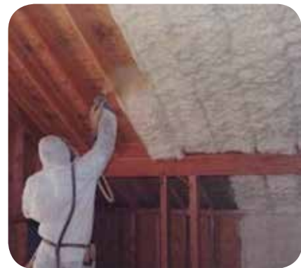
Figura 5.12: Instalación aislante proyectado
