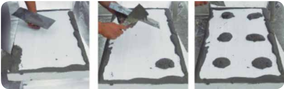
Figura 5.27: Colocación del adhesivo en la plancha aislante
