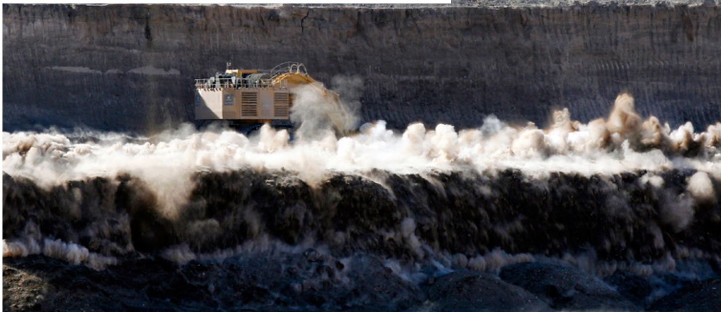
Fin del prestripping, se tuvo que remover 228 millones de toneladas de material estéril, equivalentes a 70 veces el cerro Santa Lucía de Santiago. Gentileza Codelco.
