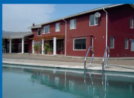
Vivienda unifamiliar Rancagua - Ciudad Rancagua, 700 m2
