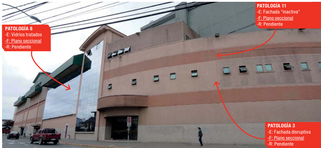
Imagen 37: Patologías y virtudes identificadas en tramo de la calle Baeuchef.
