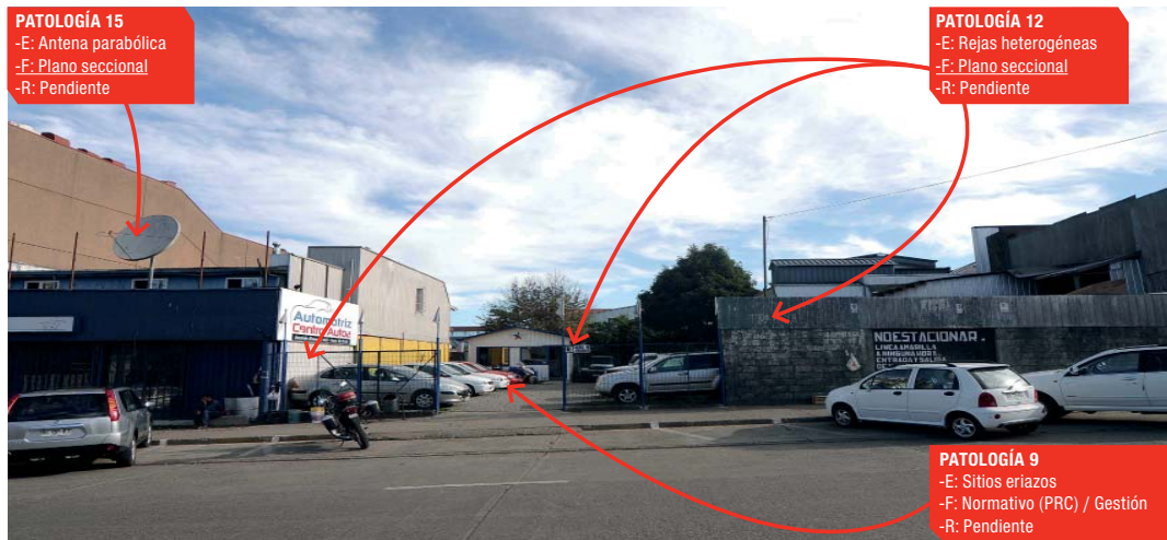
Imagen 40: Patologías y virtudes identificadas en tramo de la Av. Alemania.
