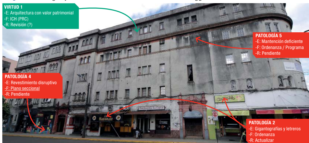
Imagen 39: Patologías y virtudes identificadas en tramo de la calle O'Higgins.
