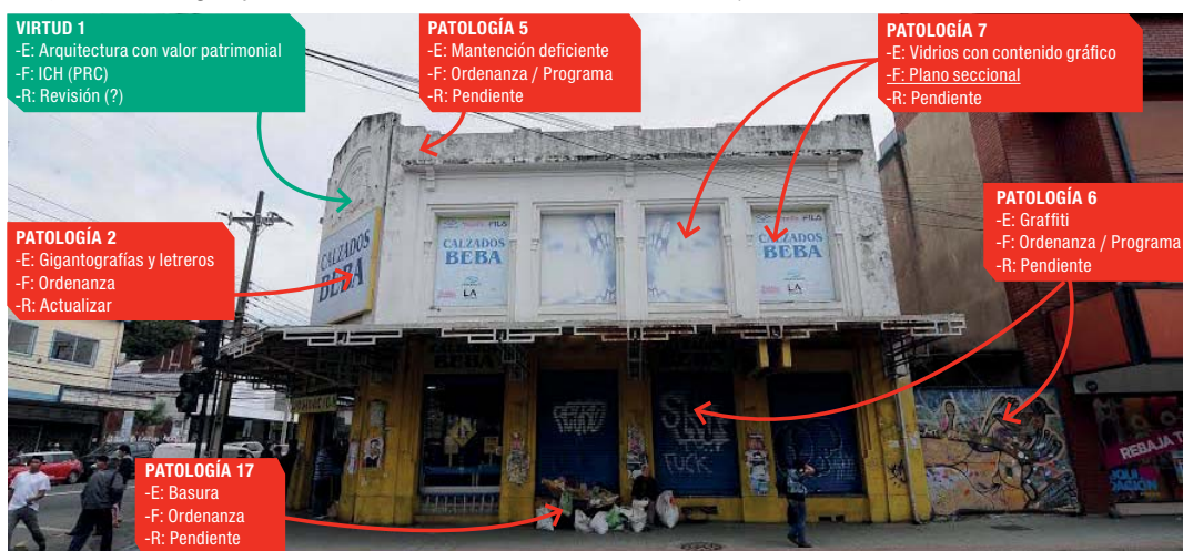
Imagen 19: Patologías y virtudes identificadas en tramo de la calle Caupolicán.
