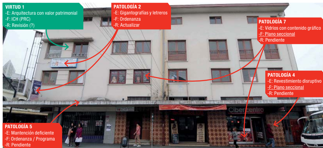
Imagen 15: Patologías y virtudes identificadas en tramo de la calle Chacabuco.
