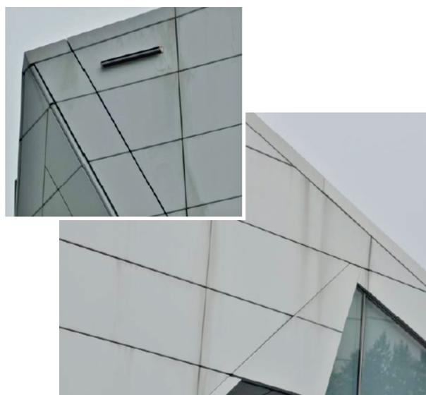
Figura 14.4. paneles ACM con junta abierta.
