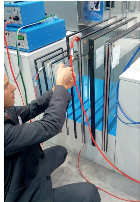
**Figura 5.10.** Llenado con gas de la cámara de un cristal DVH.
