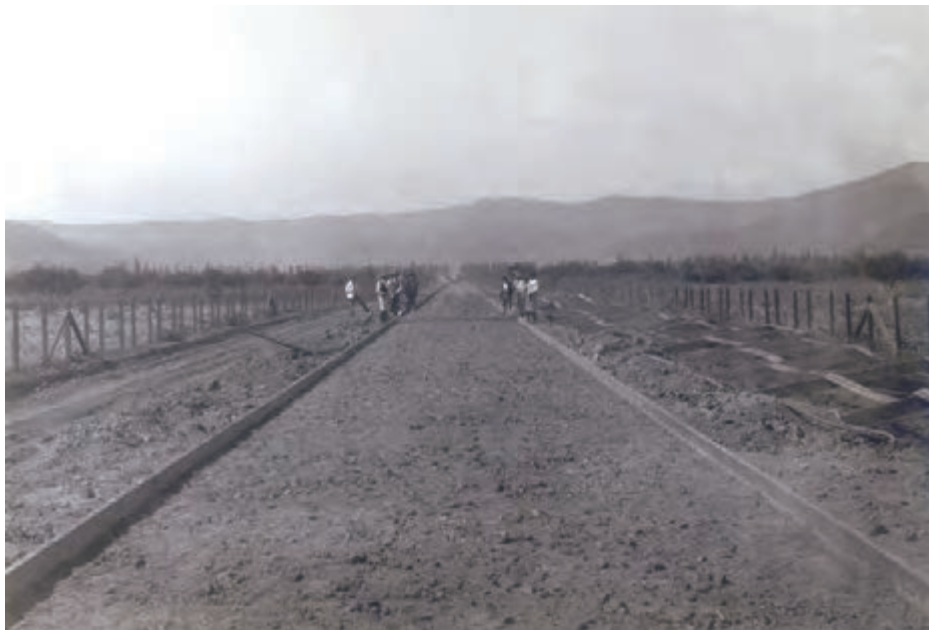
Obras de transformación del camino entre Marruecos y Curacaví, 1930c, en Archivo Fotográfico Museo Histórico Nacional
