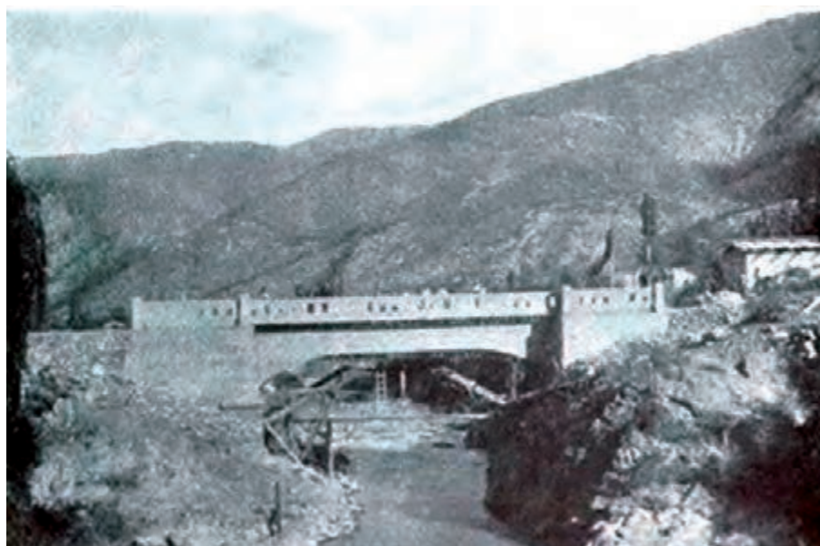
Transformación del puente Las Vizcachas sobre le río Aconcagua, en Boletín de caminos , 1930.
