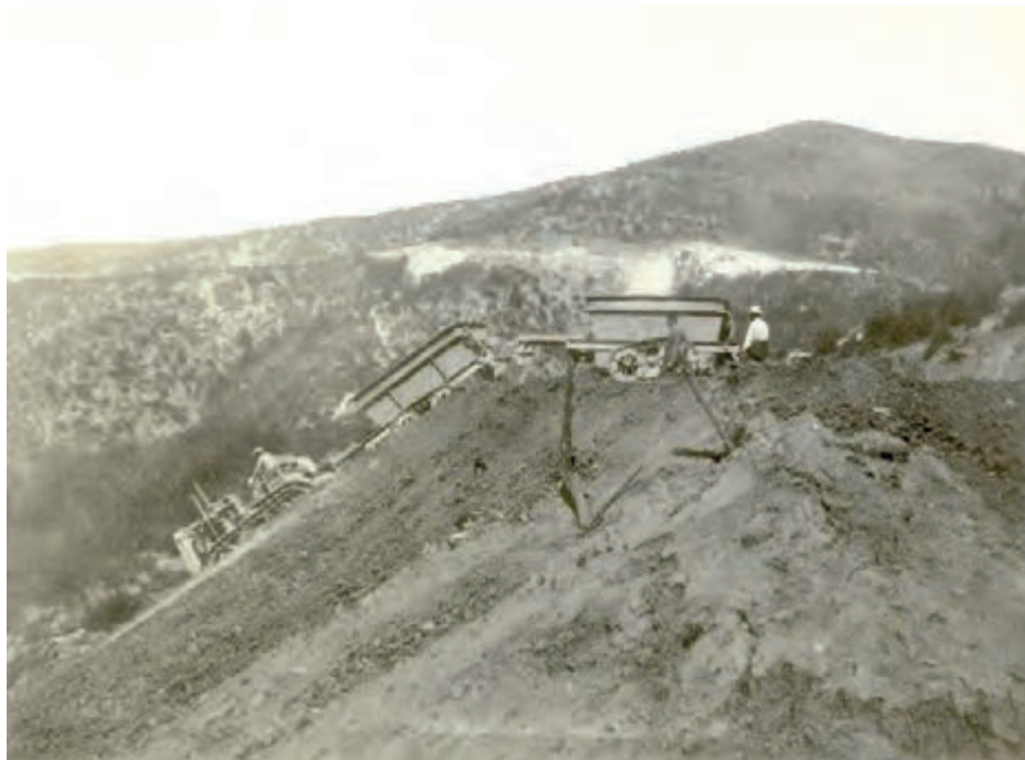
Maquinaria en la construcción del camino entre Marruecos y Curacaví, 1930c.
