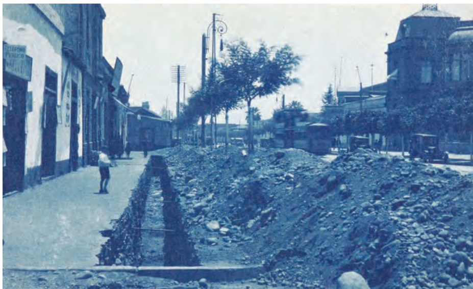
Trabajos de alcantarillado en calle Independencia, de avenida Bernardo O'Higgins al norte. Colección Museo Histórico De Chile
